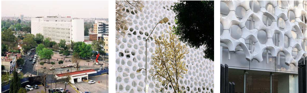
Şekil 5. Manuel Gea Gonzalez Hastanesi’nin duman yiyen cephesi; solda genel görünüm; ortada cephenin yakından görünümü; sağda cepheden detay[12].
