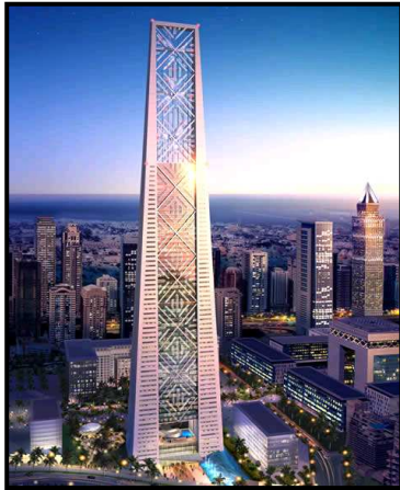
Resim 4. Atkins Lighthouse Binası Bütününde Pv Panel Uygulaması
