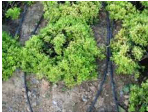
Resim 5. Çatı Bahçesinde Uygulanan Damlama Sulama Sistemine Örnek (8)
