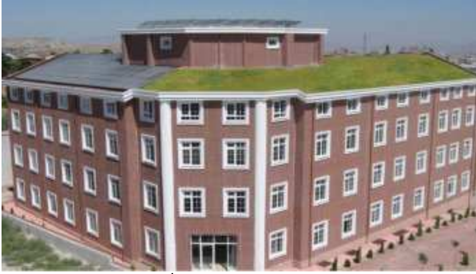
Resim 8: Nevşehir H. Avni İncekara Fen Lisesi Yurt Binası, çevre dostu çatı uygulaması
