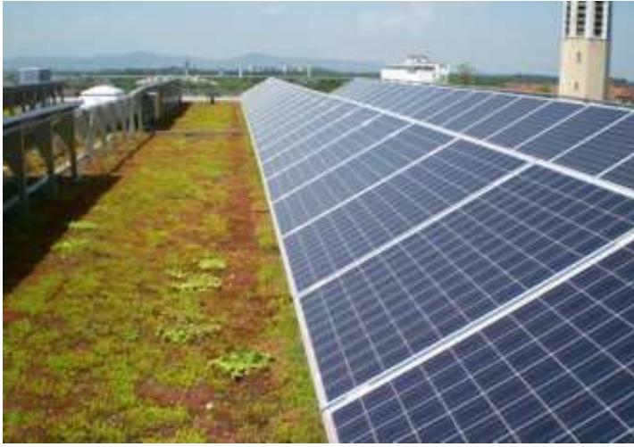
Resim 5: Yeşillendirme ve panel uygulama sonrası
