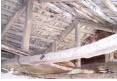
Resim 4.a. Kiremit altı ahşap kaplama
