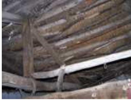
Resim 4.f. Kiremit altında ağaç dalı üzeri çavdar sapı kaplama
