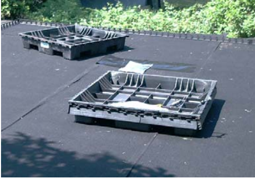
Resim 8. Yeşil Çatıda Kullanılan Modüler Elemanlar
