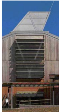
Resim:5: Yatay ve düşeyde güneş kontrolüne imkan sağlayan cephe elemanları.
