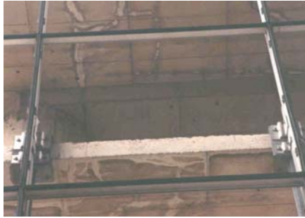
Resim 3. Yatay ve dikey kayıt elemanlarının betonarme sisteme montajı
