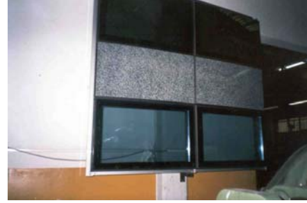
Resim 7. Yarı panel sistem uygulaması
