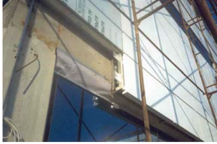
Resim 7. Yarı panel sistem uygulaması
