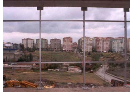
Resim 3. Yatay ve dikey kayıt elemanlarının betonarme sisteme montajı
