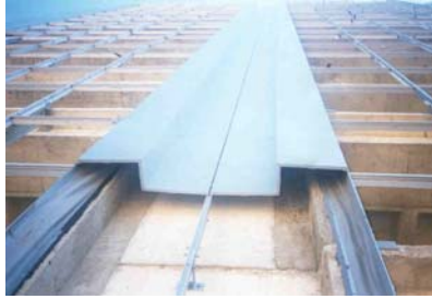
Resim 5. Yalıtıma destek olarak kaplama altına uygulanan membran örtüler
