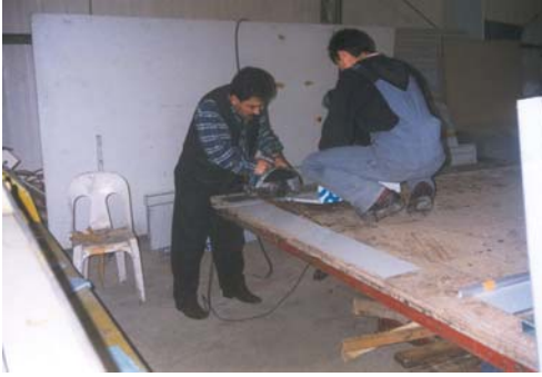
Resim 2. Alüminyum kompozit panellerin şekillendirilmesi
