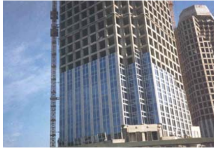
Resim 8. Panel sistem uygulaması
