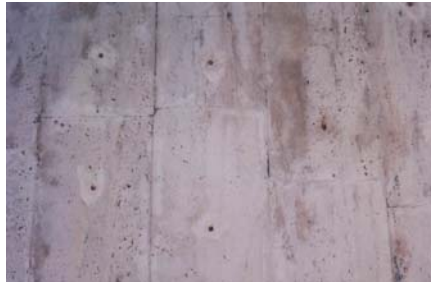
řekil 6. Dūřen kaplamalar paslanabilen, kalitesiz dūbeller ile cepheye tutturulmaya alıřılmıřtır.
