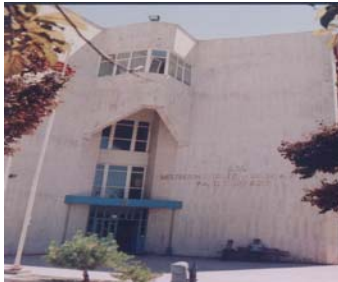
řekil 5. Cephede doęal tař kaplama kullanılmıřtır.
