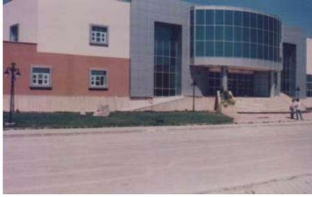
řekil 3. Kamuya ait binanın subasman seviyesine kadar doęal tař kaplama kullanılmıřtır.
