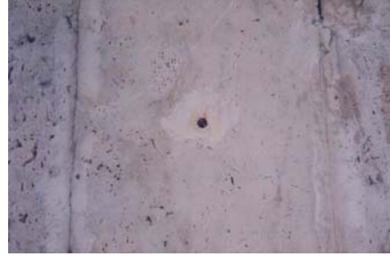
řekil 2. Dūřen doęal tař kaplamalar sonradan cepheye vidalarla tutturulmuřtur.
