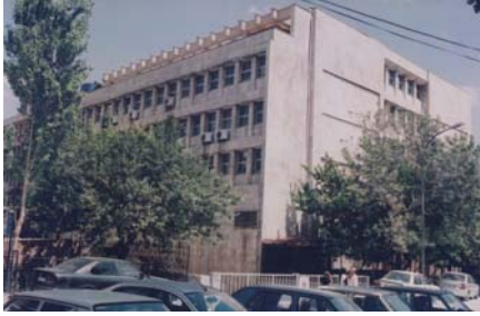
řekil 1. Kamu yapısı cephesindeki doęal tař kaplama har ile uygulanmıřtır.
